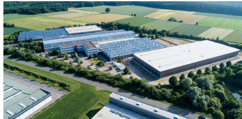
Машиностроительный завод Paul в Дюрментингене (2025)
