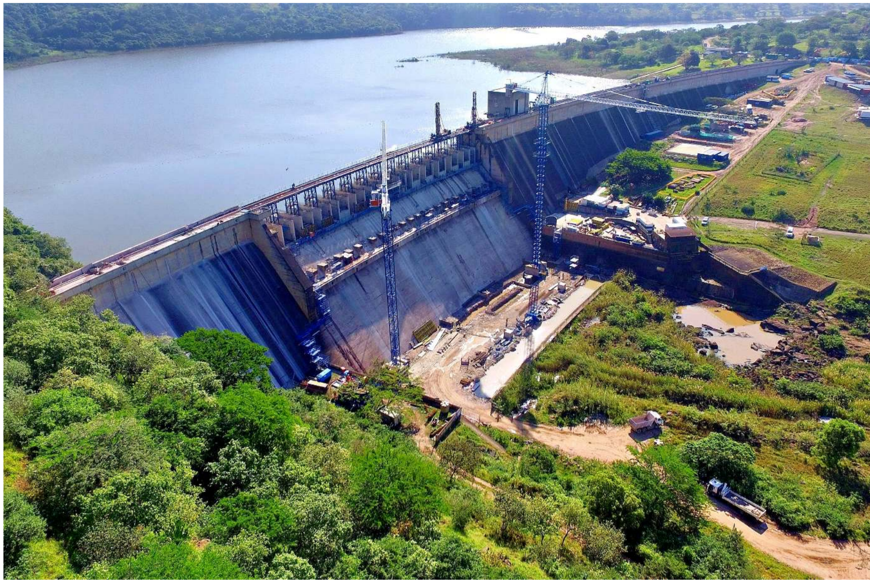
Der Hazelmore-Damm in Südafrika während der Kapazitätserweiterung.
